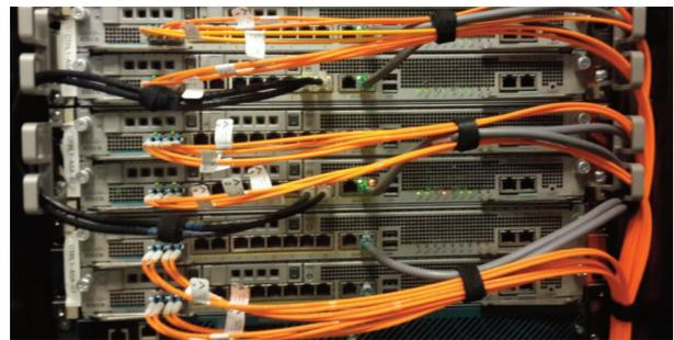
Cableado de Fibra Óptica con transferencias a 10 Gb
